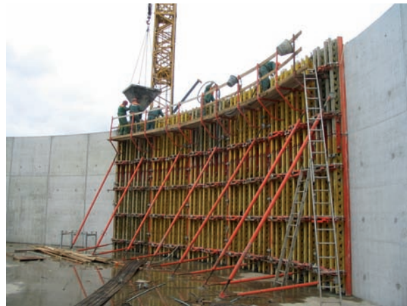
4 pav. Rezervuaro aukštos sienutės nenutrūkstamas betonavimas
