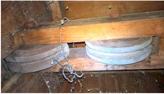
14 pav. Maisto keltuvo šachtos viršuje esantys mediniai skriemuliai (M. Daraškevičiaus nuotr., 2016)
