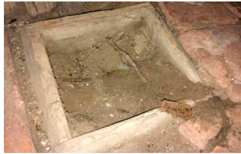
15 pav. Pirmame aukšte grindyse specialioje įgilintoje medinėje dėžėje šalia lyno kanalo apačios įtaisyta metalinė klampė (M. Daraškevičiaus nuotr., 2016)
