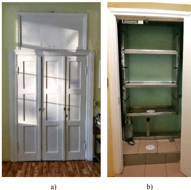
7 pav. Buvusių Pagryžuvio dvaro rūmų maisto keltuvo pirmo aukšto šachtos angos durys (a); cokolinio aukšto šachtos anga (b) (M. Daraškevičiaus nuotr., 2017)
