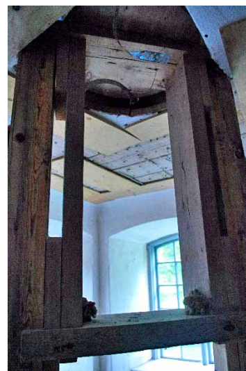
2 pav. Apatiniame aukšte esančio vieno iš keturių apvalių servantų pakėlimo mechanizmas, 1763 m. (Lasse Brundin nuotr., 2016)
