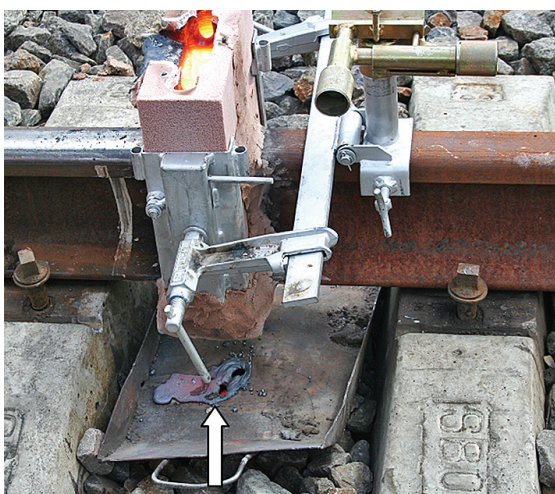
4 pav. Išlydyto metalo išsiliejimas iš keraminės formos Fig. 4. A spill of molten metal from a ceramic form
