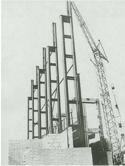
5 pav. Petrašiūnų dolomitinės skaldos gamyklos kompozitinių kolonų montavimas
